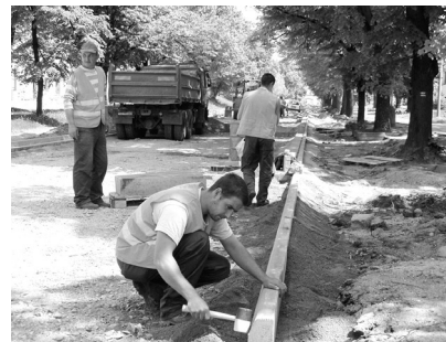
V týchto dňoch je v priestoroch Námestia svätého Martina čulý stavebný ruch. Najneskôr do konca mája by mala byť dokončená vozovka, ktorá v prvej fáze bude počas rekonštrukcie svetelnej križovatky slúžiť ako časť obchádzkovej trasy.
